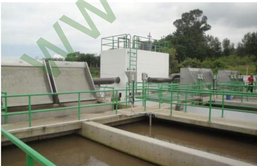
→ Vue d'une station avec crible statique VS
