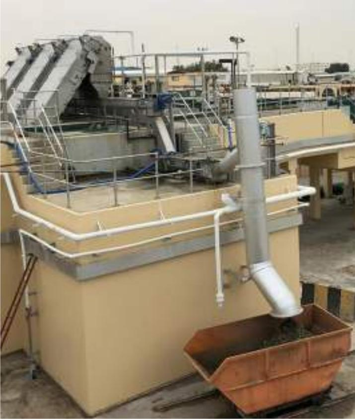
Le matériau solide retenu par les dégrilleurs des stations d'épuration des eaux usées civiles ou industrielles présent souvent l'inconvénient de contenir beaucoup d'eau et/ou matière fécale, ce qui entraîne une augmentation des coûts de stockage et de transport. Les compacteurs résolvent le problème en lavant, compactant et asséchant le matériau de dégrillage.
