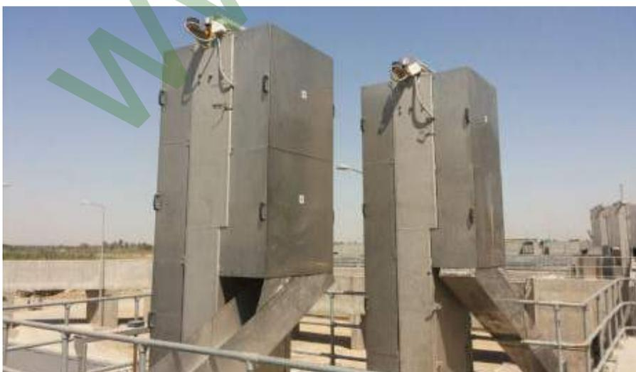
➔ Vue d'ensemble d'une station avec dégrilleur plat vertical à câble GPSC
