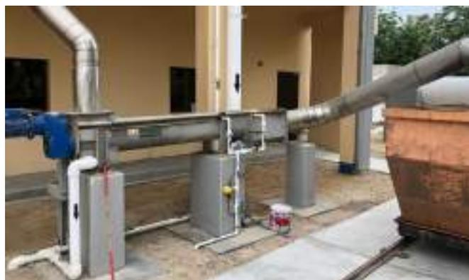
→ Compacteur-convoyeur du matériau de dégrillage à vis.
