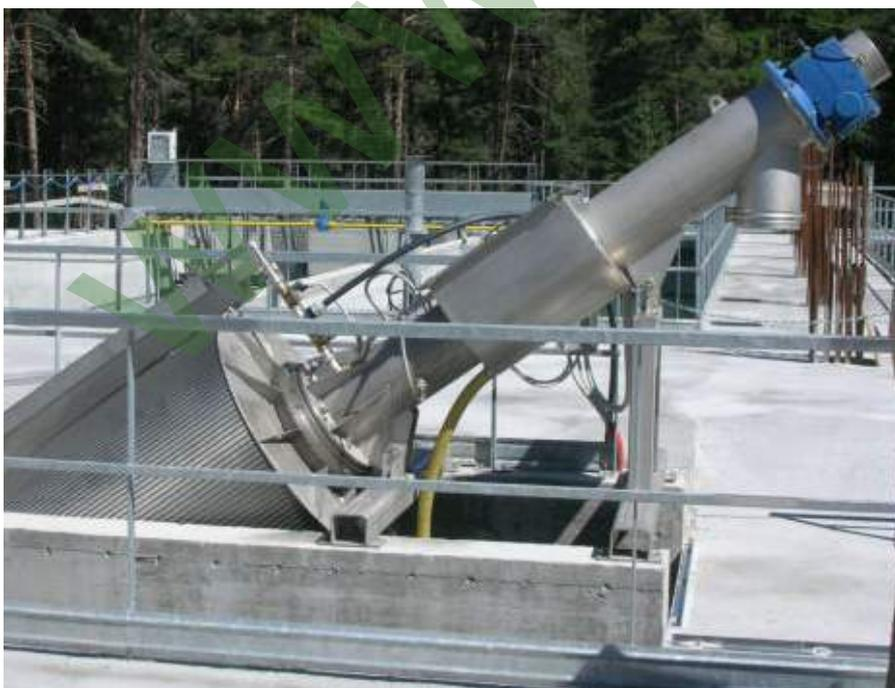
➔ Vue d'ensemble du système avec filtre à vis FSSM
