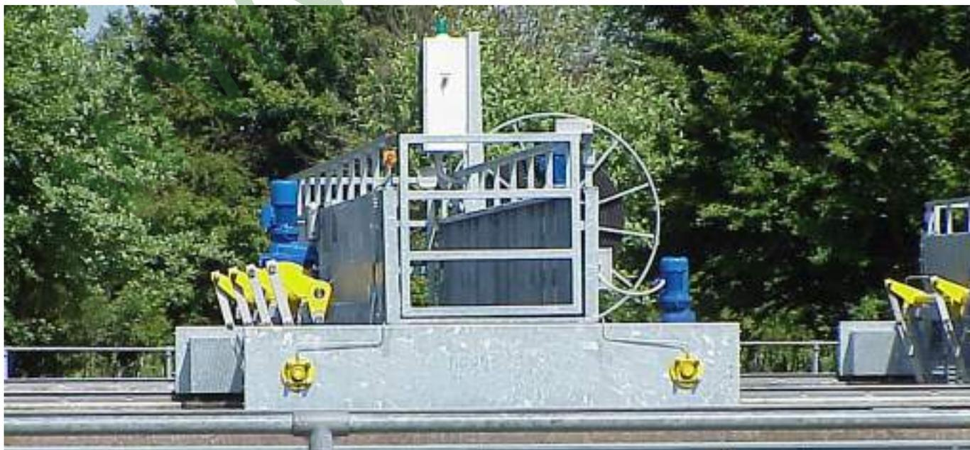
→ Racleur en “va-et-vient” pour décanteur rectangulaire
