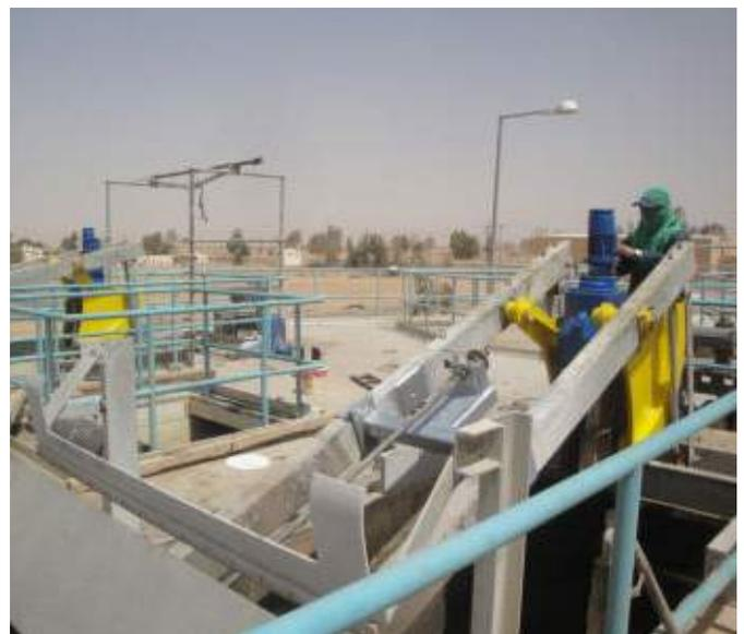
➔ Vue d'ensemble d'une station avec dégrilleurs type GCMR
