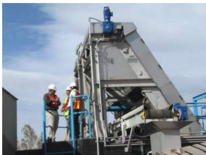
→ Vue d'ensemble d'une station avec dégrilleur plate mobil sub-vertical à mouvement alterné GPSA
