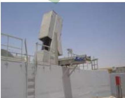
→ Vue d'ensemble d'une station avec dégrilleur plat sub-vertical GPSR
