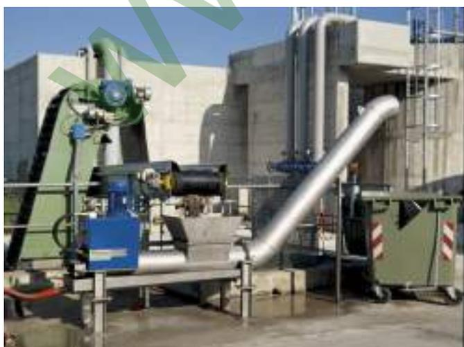
→ Compacteur-convoyeur hydraulique
