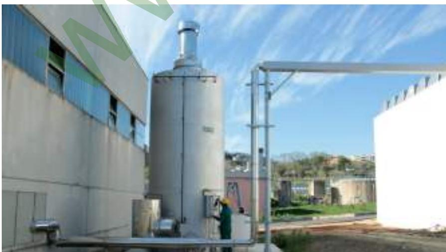
→ Filtre pour le traitement des odeurs du type biotrickling
