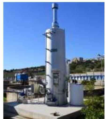
→ Filtre pour le traitement des odeurs du type biotrickling
