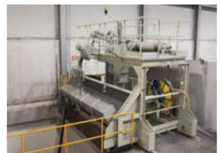
→ Dégrilleur automatique à benne pendulaire SGPSA
