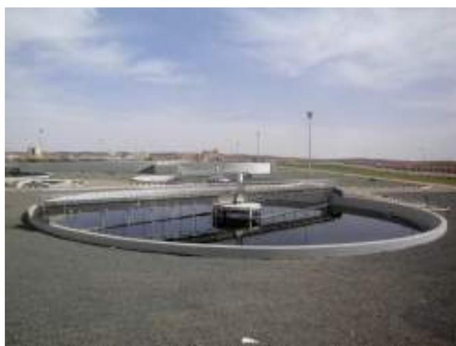
➔ Racleur à traction périphérique diamétrale pour décanteur circulaire
