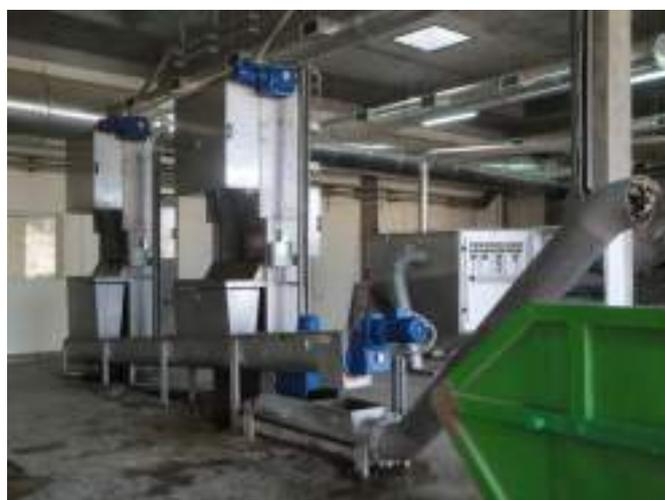
→ Compacteur-convoyeur hydraulique
