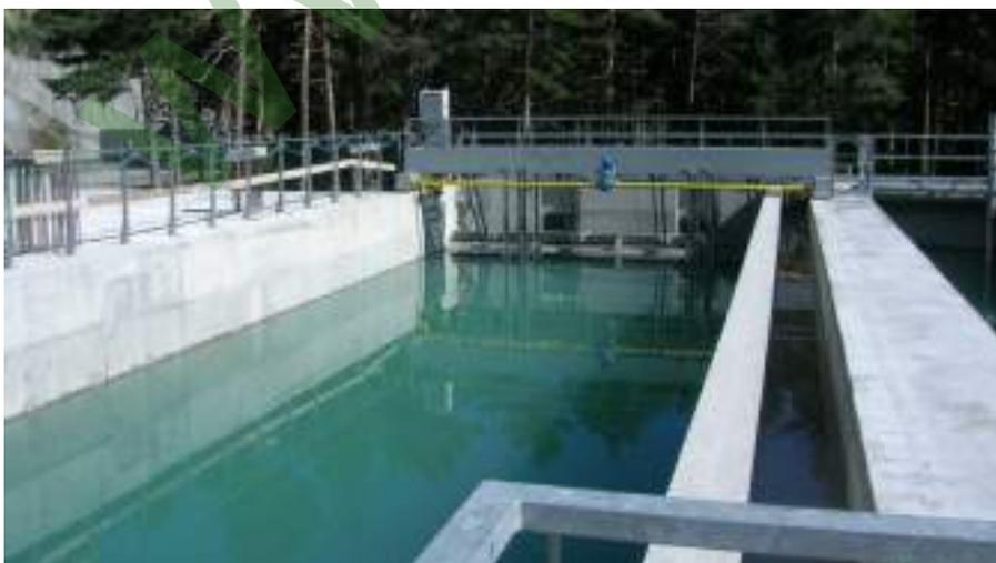
→ Aspire boues en va-et-vient pour décanteur rectangulaire
