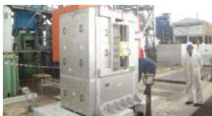
→ Vue d'ensemble d'une staton avec dégrilleur à bande à flux central GNAFO2
