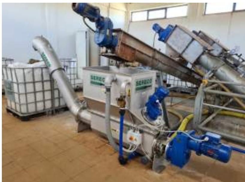
➔ Laveur et compacteur-convoyeur du matériau de dégrillage à vis
