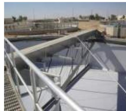
→ Rascador de accionamiento periférico de tres brazos para decantador circular
