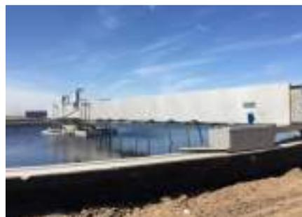
➔ Rascador aspirado de accionamiento periférico para decantador circular
