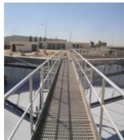
→ Rascador de accionamiento periférico de tres brazos para decantador circular
