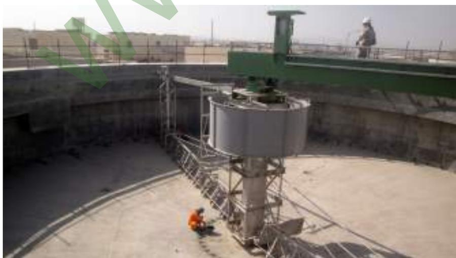
➔ Rascador controlado centralmente para decantador circular
