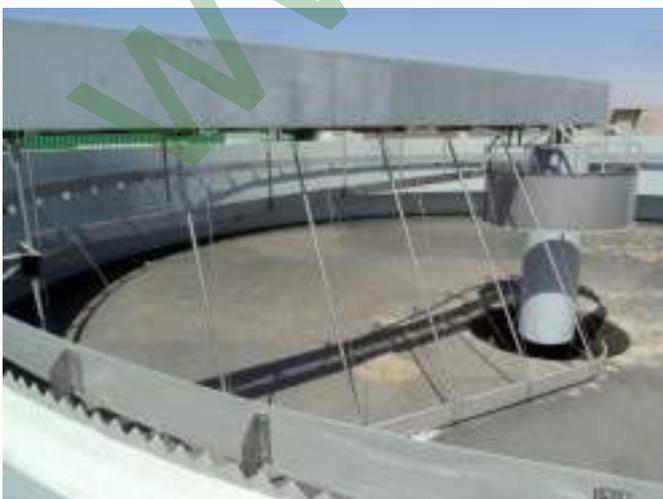
➔ Rascador de accionamiento periférico para decantador circular
