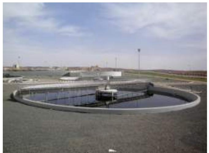
→ Rascador de tracción periférica de diámetro para decantador circular
