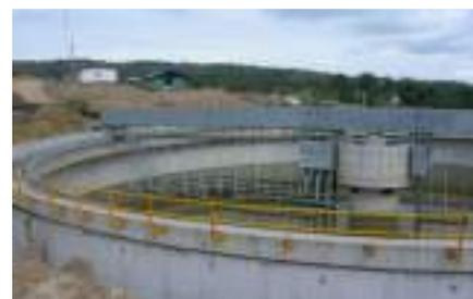
➔ Raspador aspirado con tracción periférica diametral
