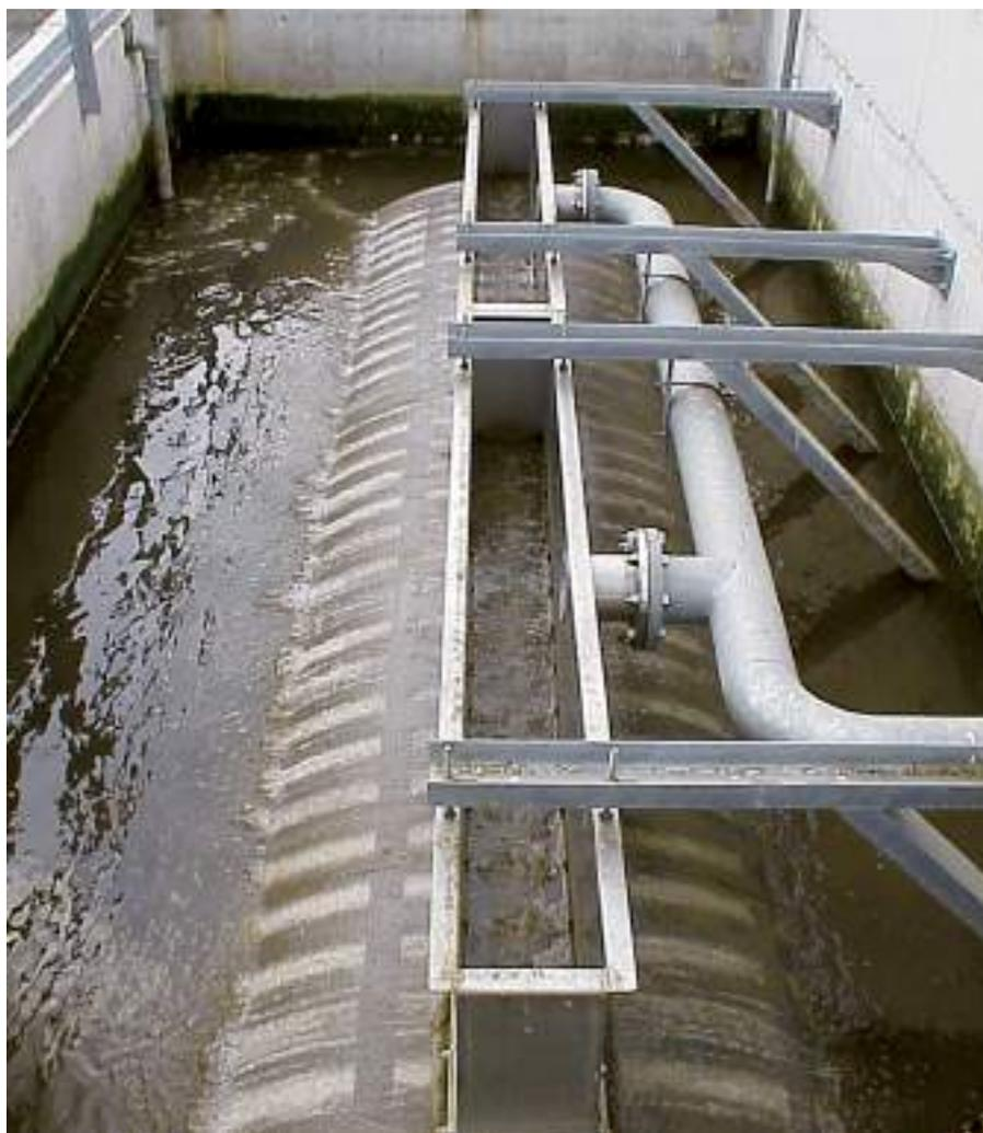
➔ Panoramica d'impianto con filtro per acqua a controlavaggio automatico
