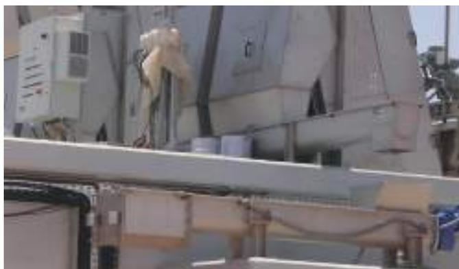
→ Panoramica d'impianto con compactatore-trasportatore del grigliato a coclea
