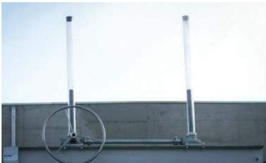
è AISI 420. Tale materiale risulta adatto in quanto la sua struttura martensitica garantisce elevate proprietà meccaniche e contemporaneamente **riduce il rischio di grippaggio** anche in condizioni di scarsa lubrificazione.
