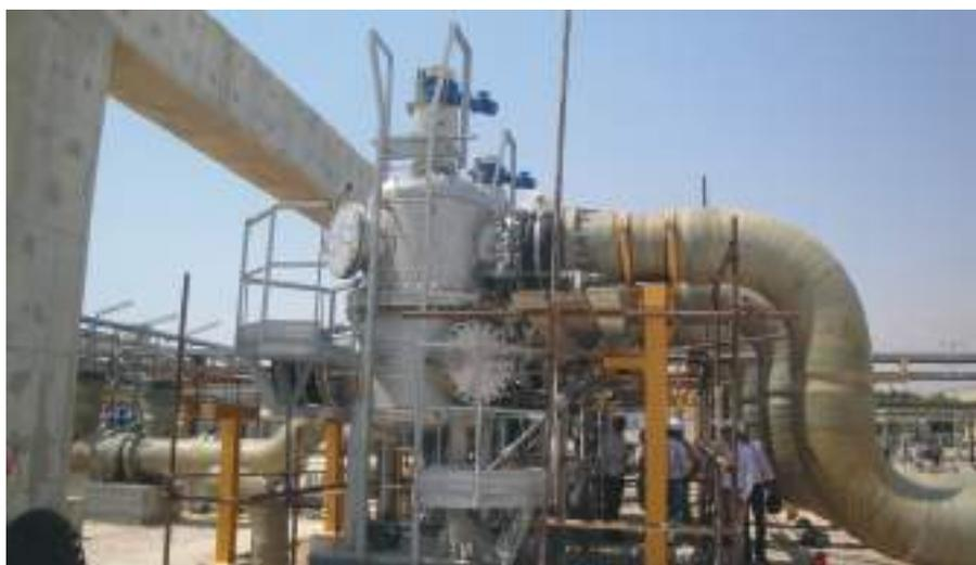
➔ Panoramica d'impianto con filtro per acqua a controlavaggio automatico
