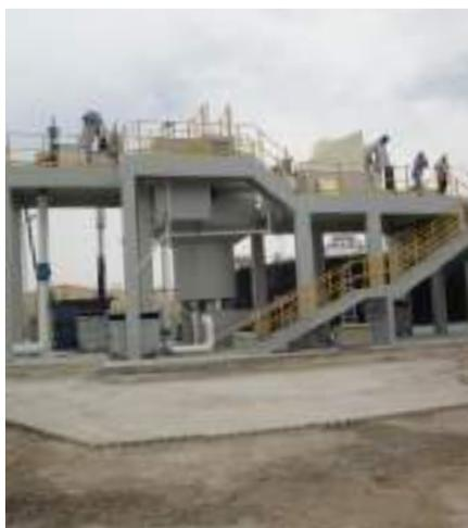
→ Panoramica d'impianto con dissabbiatore a pale rotanti con disoleatore
