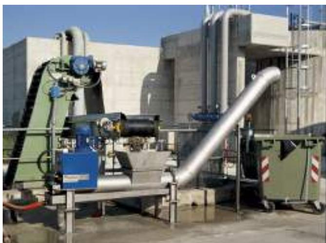
➔ Compattatore-trasportatore oleodinamico
