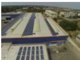
Tutte le macchine SERECO sono prodotte con energia pulita. L'impianto fotovoltaico installato, avente potenza nominale di 250 kW, è sufficiente a rendere totalmente indipendenti dalla rete elettrica nazionale consentendo di provvedere autonomamente al fabbisogno elettrico giornaliero di uffici e stabilimento produttivo, con ridotto impatto ambientale.
